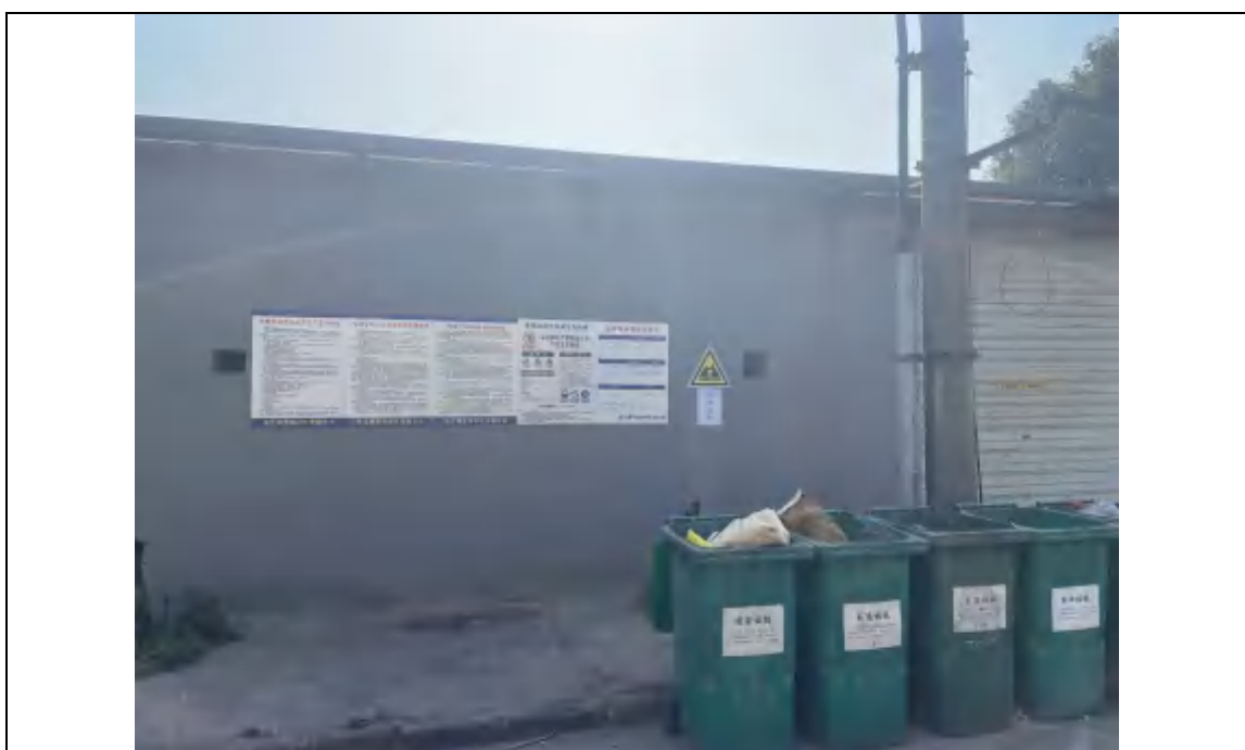
厂区南侧危废仓库外部
