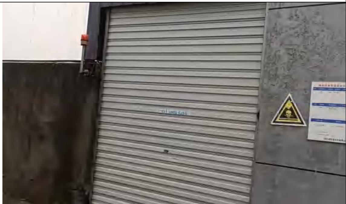
厂区北侧危废仓库外部
