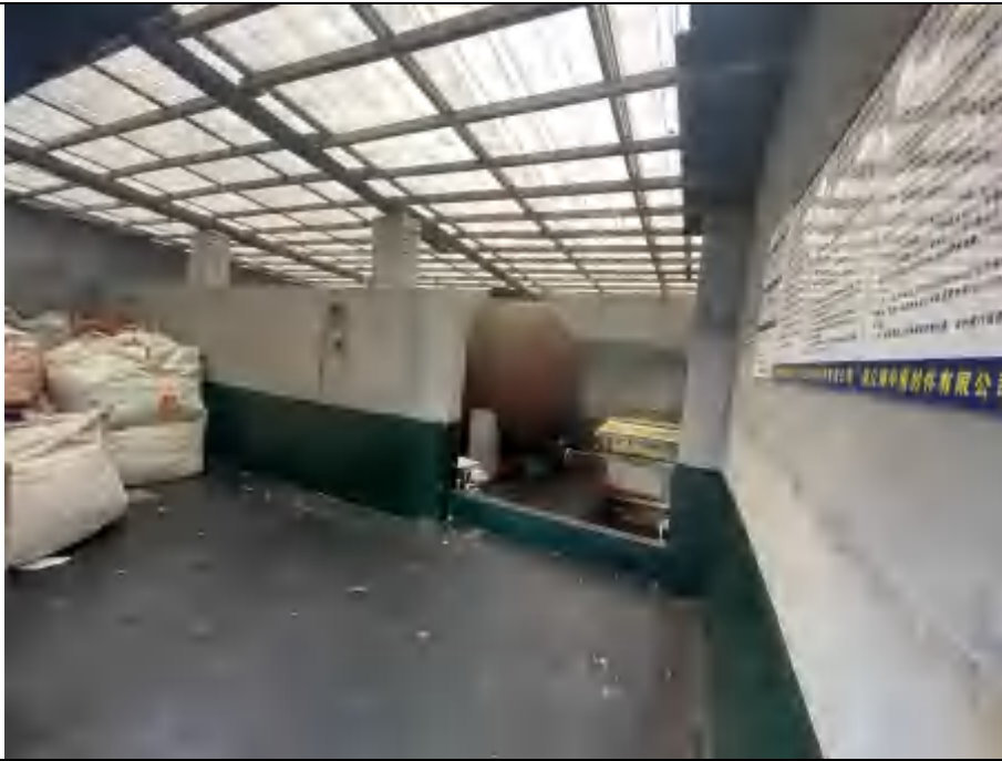
厂区南侧危废仓库内部
