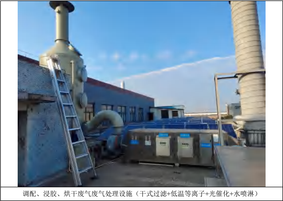
图 4-4 本项目废气治理现场相关照片
