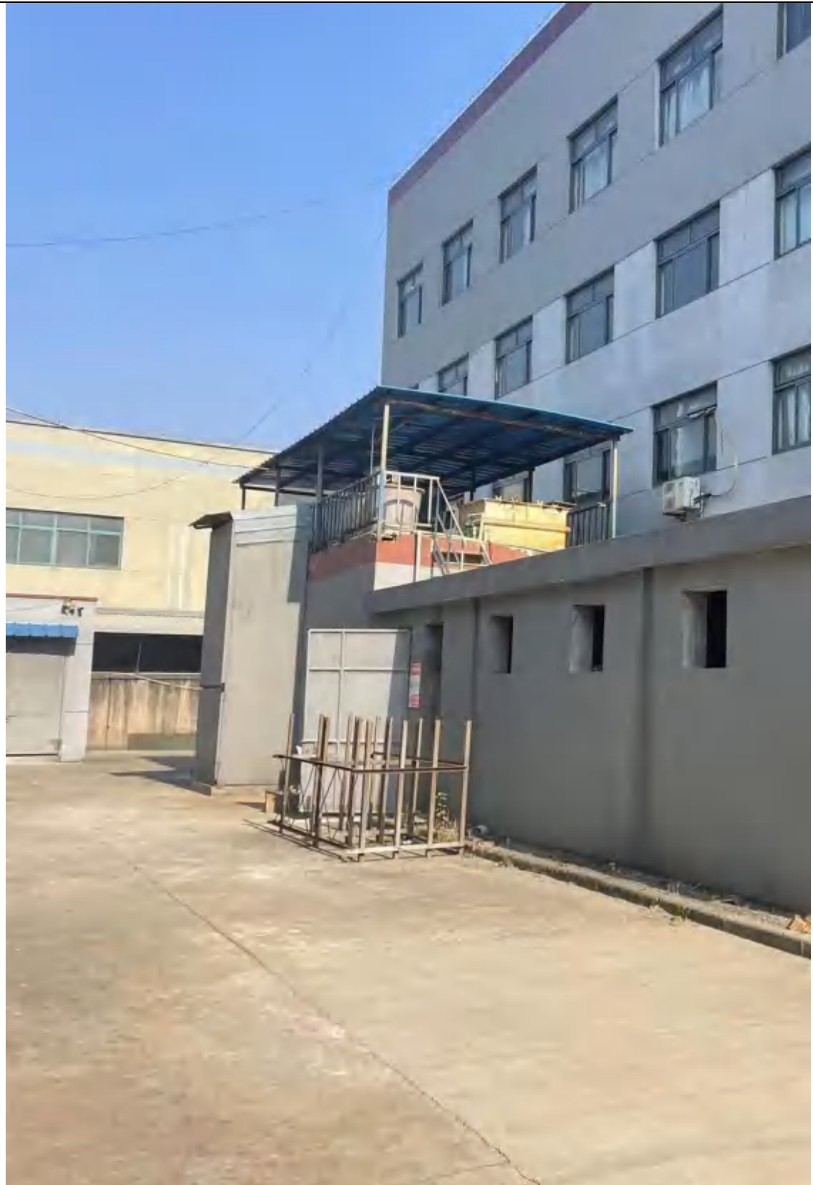
废水处理设施（混凝沉淀+活性炭吸附）
