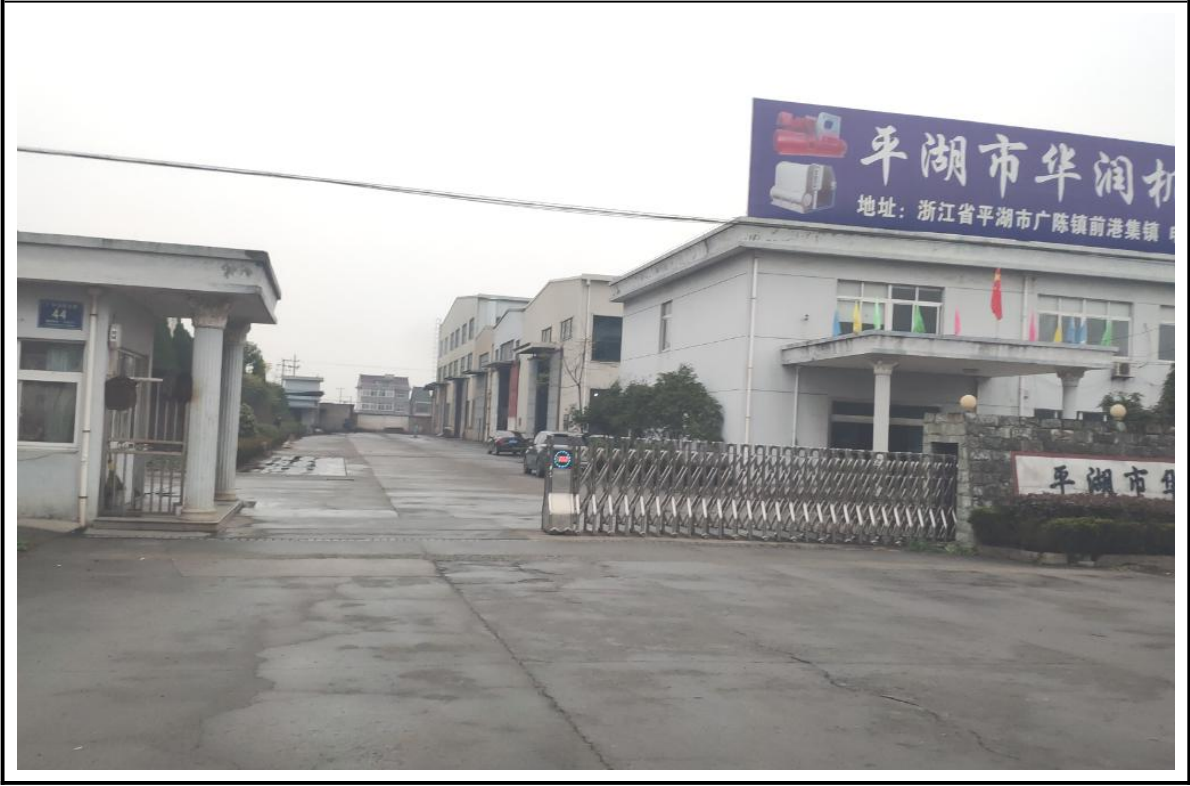
项目现场照片
